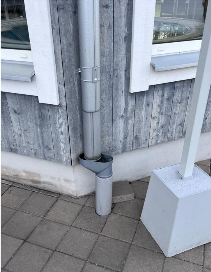
Figur 4-4. Befintligt stuprör anslutning till planområdet.
