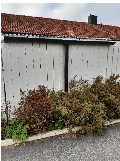
Figur 34. Exempel på befintligt lokalt omhändertagande av dagvatten direkt till rabatt inom kvarteret Topasen 2 (Foto: VME)
