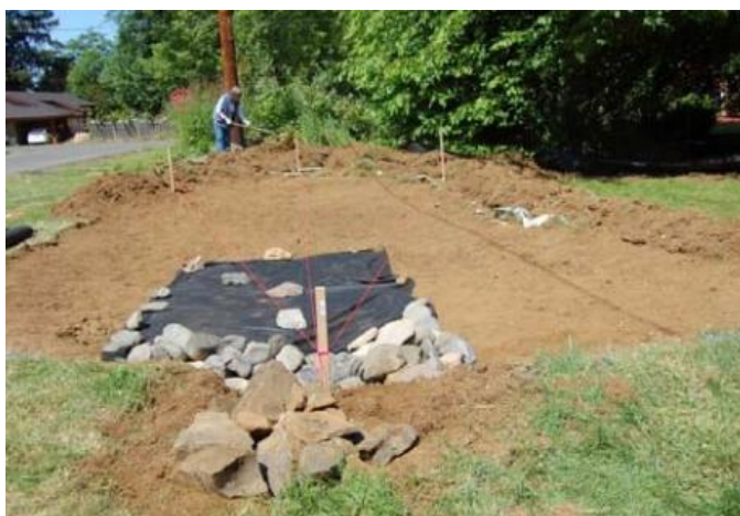
Figur 33. Erosionsskydd vid överfall av naturligt stenmaterial minskar risken för bortspolning av material vid större flöden (Foto: Oregon Sea Grant, 2009)
