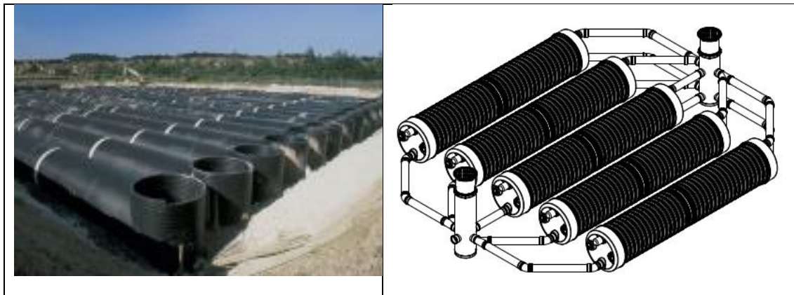
Figur 29. Exempel på större rörmagasin, samt typritning från Uponor (Foto: Stockholm Vatten och avfall, ritning från Uponor).
