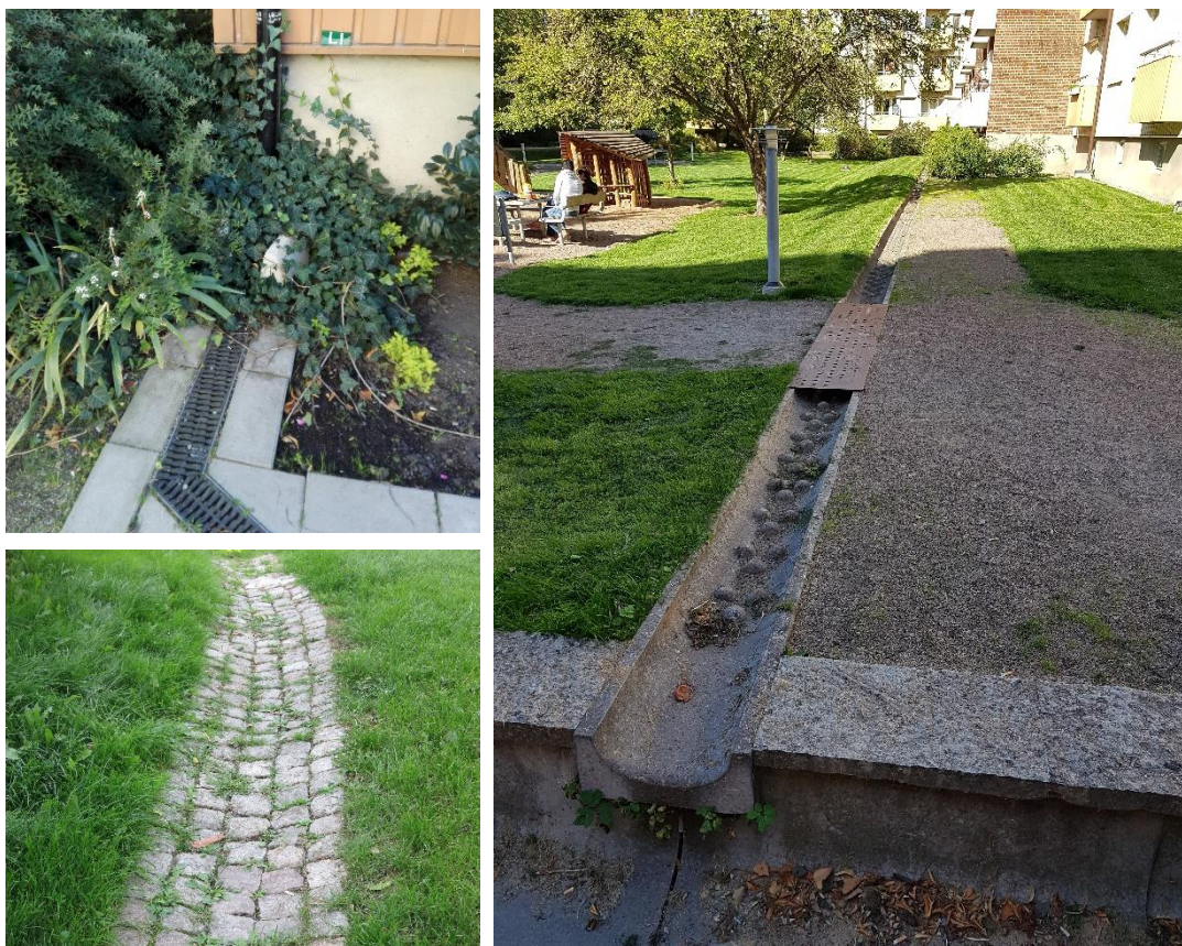
Figur 28. Exempelbilder på olika typer av rännor för ytlig avledning av takvatten (Foto: Tyréns)
