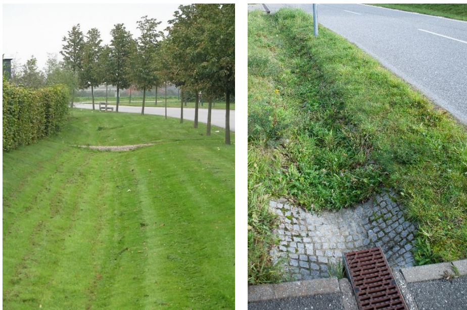
Figur 23. Exempelbilder på svackdiken (Foto: Tyréns)
