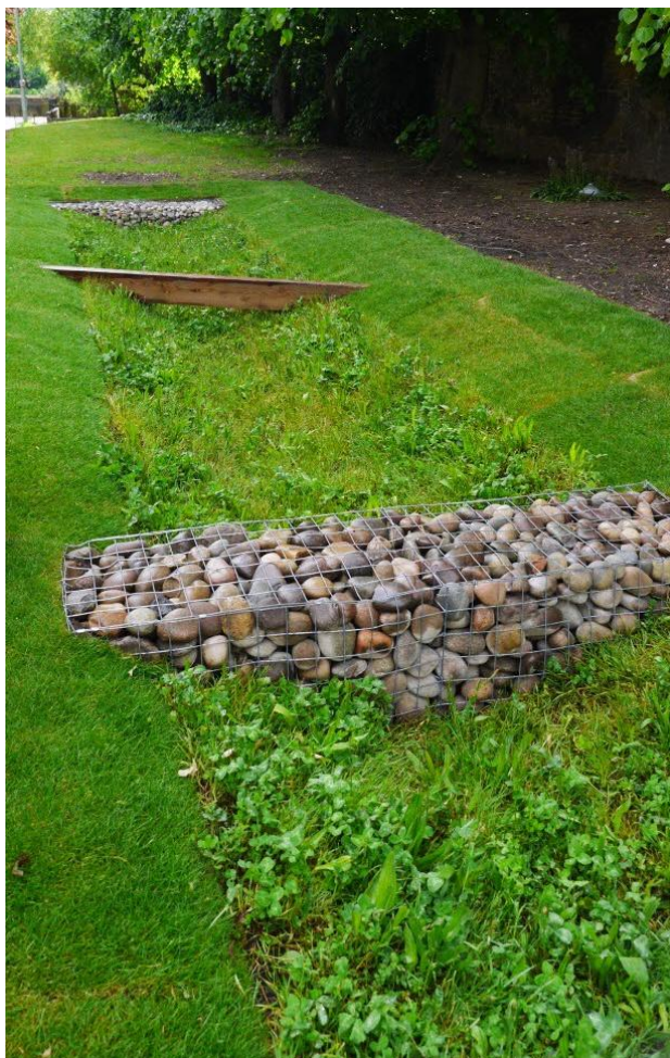
Figur 32. Exempelbild på ett trappat dike som fördröjer och utjämnar dagvatten, t.ex. vid skyfall (Foto: Boverket, 2020)
