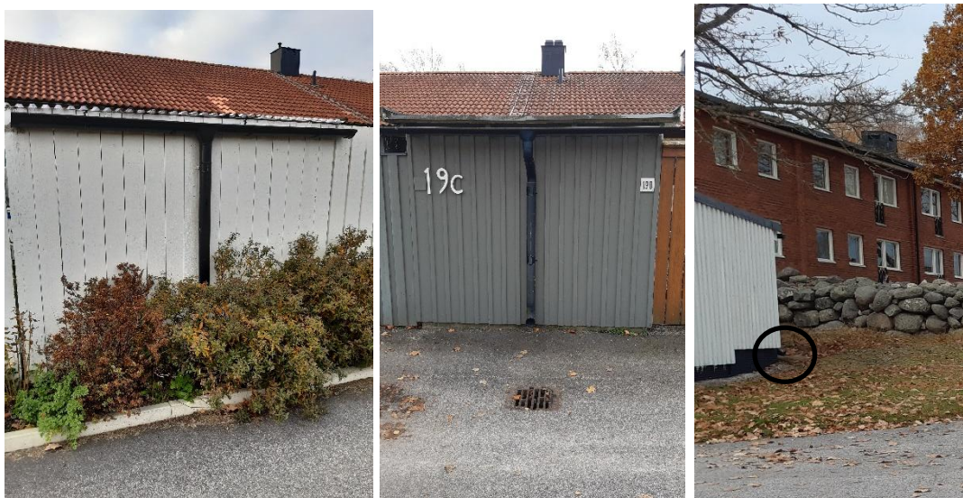
Figur 12. Exempel på avvattning av takytor för komplementbyggnader och garage inom kvarteret Topasen 2. Utkastare från garagetak är markerad i svart. (Foto: VME)
