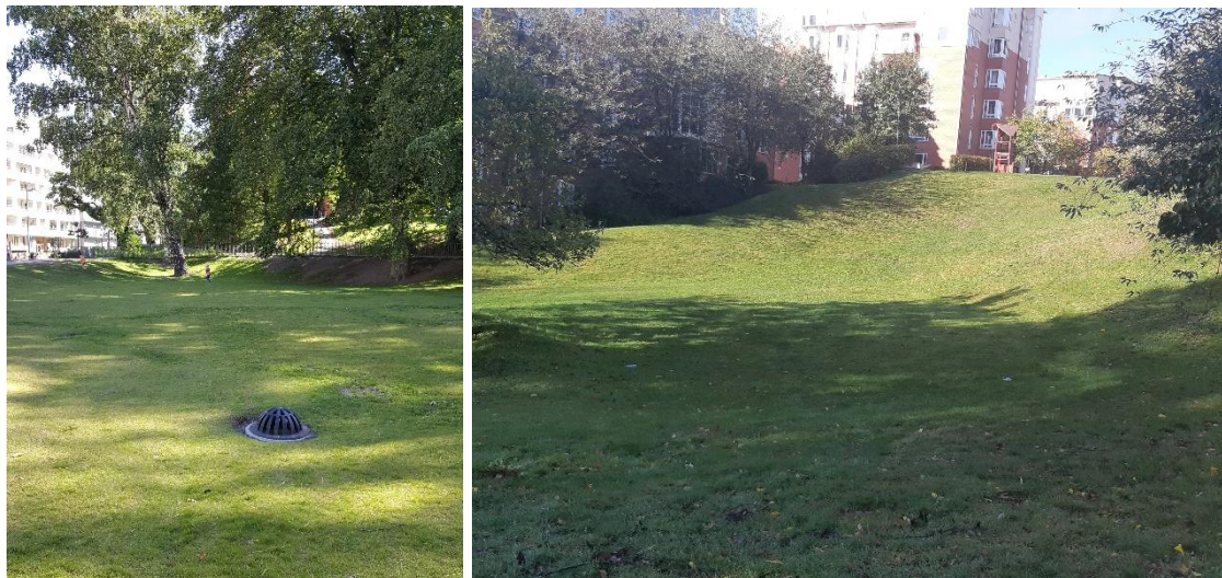
Figur 31. Exempel på större öppna ytor för utjämning med bräddavlopp. Gräsyten kan dräneras vilket innebär att ytan för det mesta är torr och utformningen anpassas till befintliga förhållanden (Foto: Tyréns)
