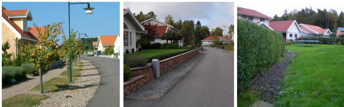
Figur 24. Exempelbilder makadamdike med krossmaterial i ytan. Diket till höger visar exempel på ett avskärande dike för att förhindra dagvatten från uppströms liggande mark att rinna in på grannfastigheten (Foto: Svalövs kommun, 2013)
