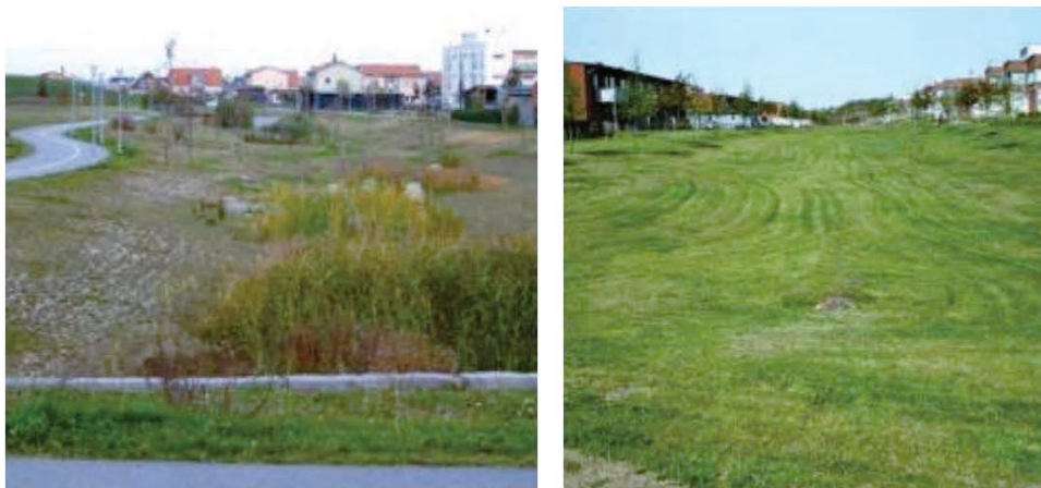
FIGUR 12: Exempelbilder avvattningsstråk och översvämningsyta som kan kombineras med regnträdgård (Dagvattenutredning, Tyréns).
