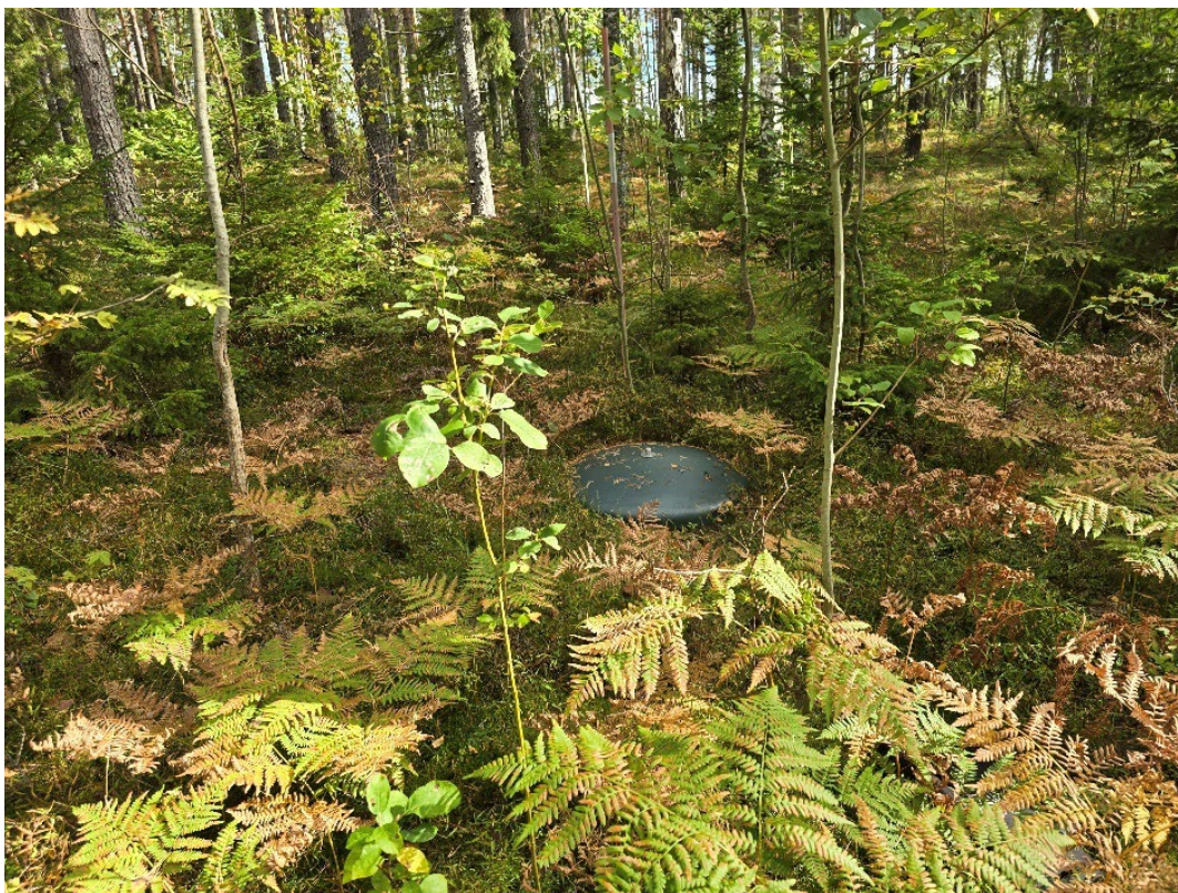
Foto 3. Foto på vattenbrunn, som nu sörjer tre befintliga fastigheter. Foto: Sweco.
