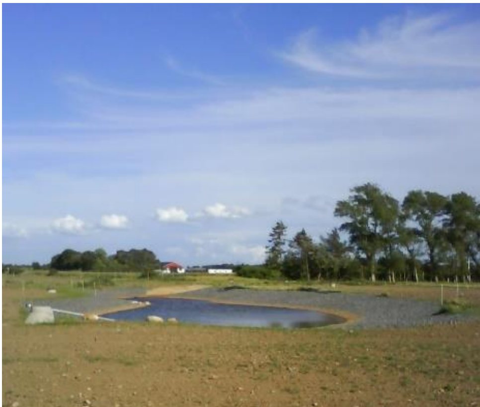
Figur 21. Exempel på damm med översilningsyta. Källa: Sweco.
