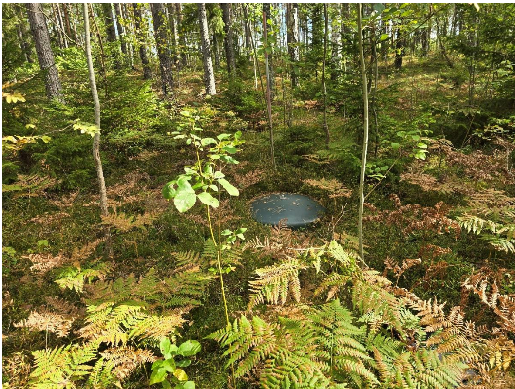
Figur 4. Bild på vattenbrunn, som sörjer nu tre befintliga fastigheter. Källa: Sweco.
