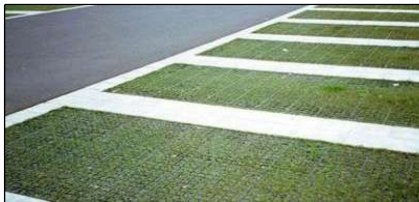
Figur 35: Lokal markinfiltration, genomsläpplig markbeläggning vid bilparkering.
