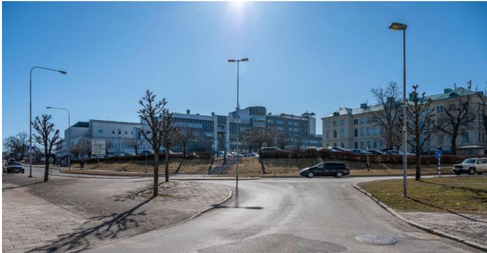
Bild 18. Vy nr 7. Befintlig situation (inkl. färdig psykiatribyggnad).
