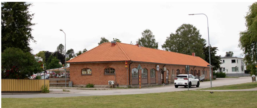
Figur 17: Foto på tegellängan från Hamngatan.
