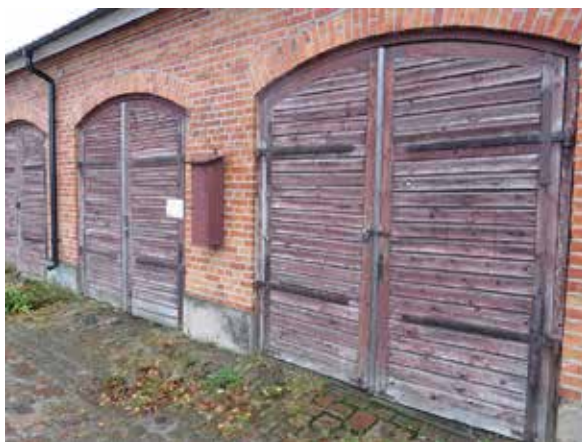
Stickbågiga portar på byggnadens norra sida.
