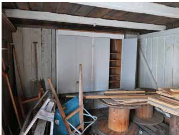
Rummet mitt i byggnaden som kan ha fungerat som vedbod och förråd för trädgårdsredskap.
