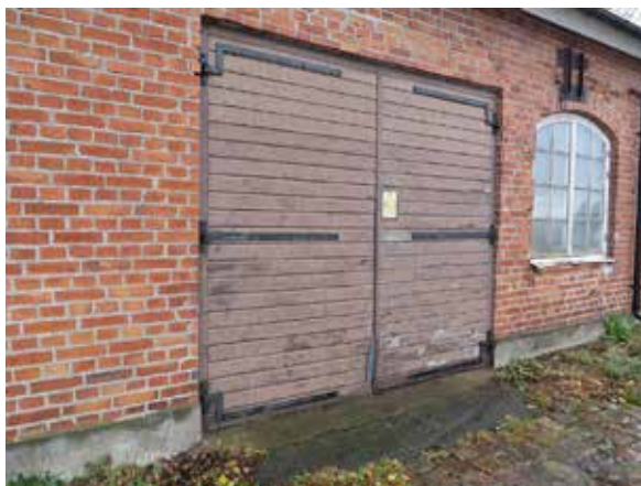
Rak port med kraftiga gångjärn och stickbågigt fönster i byggnadens östra del.
