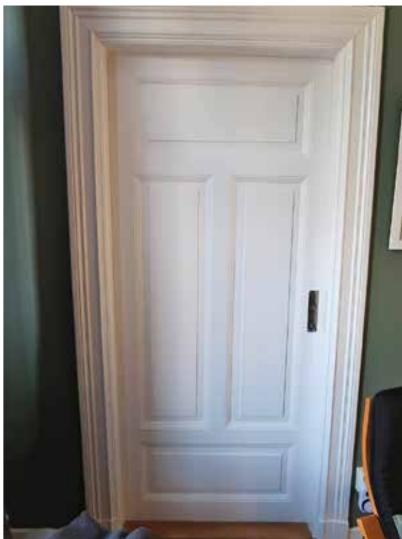
Dörr med profilerade foder och skurklossar på andra våningen.
